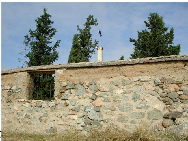
Las albardillas son de distinta factura, existiendo de distintos tipos, en los que se emplea el ladrillo de tejar visto colocado a sogas y la piedra.
